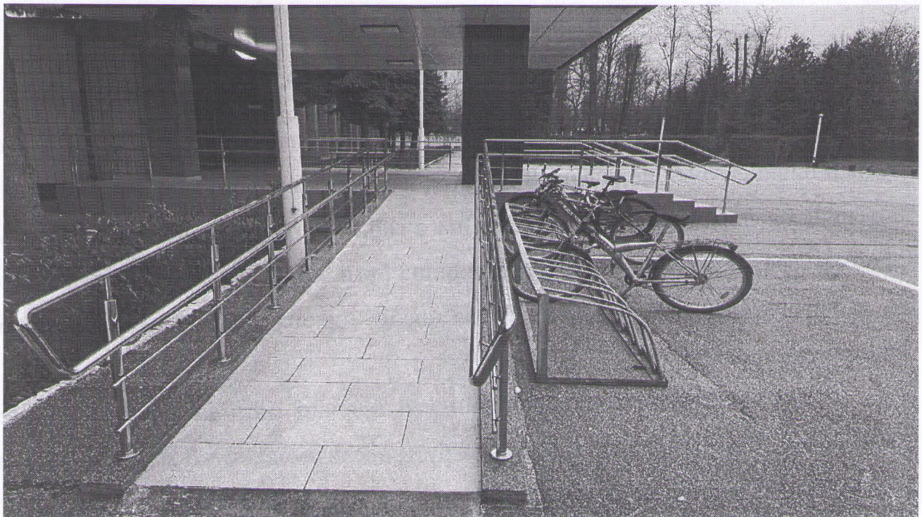
Рис. 2.4 – Загальний вигляд зовнішніх сходів
